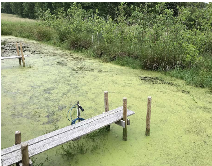
Abbildung 13: Umsetzung eines CW mit einem Fangbecken zur Sedimentation (offene Wasserfläche vorne im Bild) und einem Denitrifikationsbecken das, in diesem Fall, von dem Wasser aus dem Fangbecken durchströmt wird.
