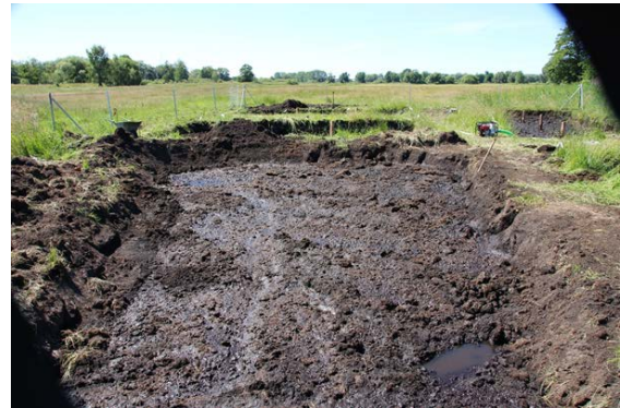
Abbildung 18: Becken E während des Baus
